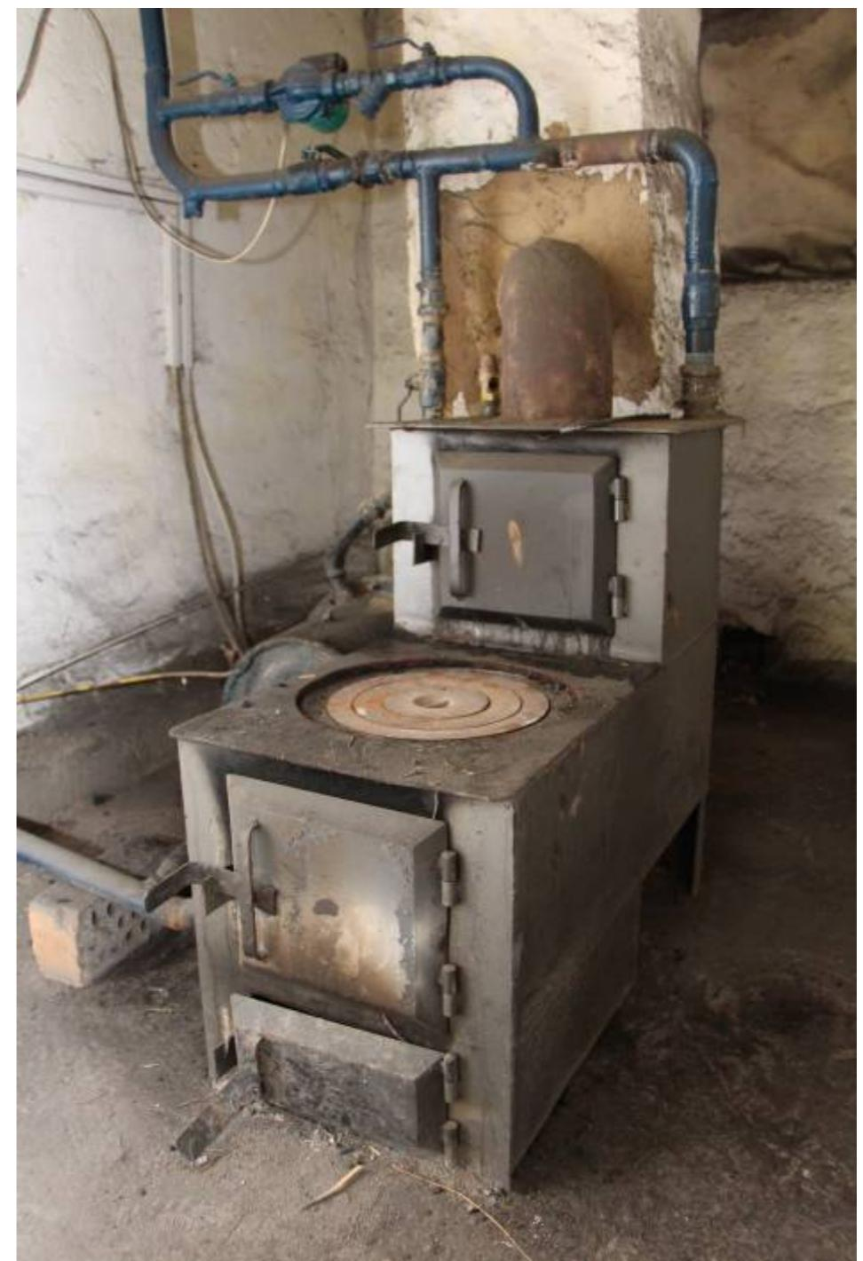
**Фото 3.** Печь отопительно-варочная Жылтыуучу - тамак даярдоочу меш
